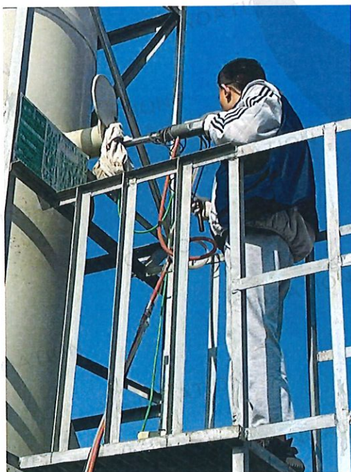
酸雾废气排放口 (FQ-16322)
